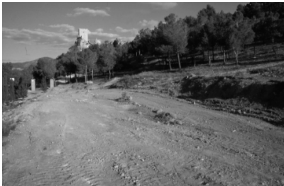
Foto 5. Movimientos de tierra para plantar pinos en la zona este de la ladera.
